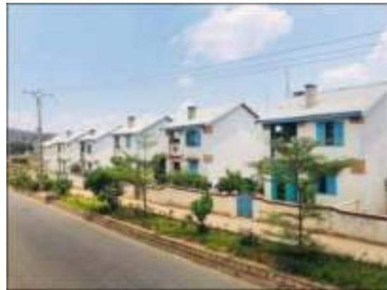
Figura 10: Viviendas del barrio Mahatsara. Fuente: Fotografía de mi autoría, diciembre de 2018.
