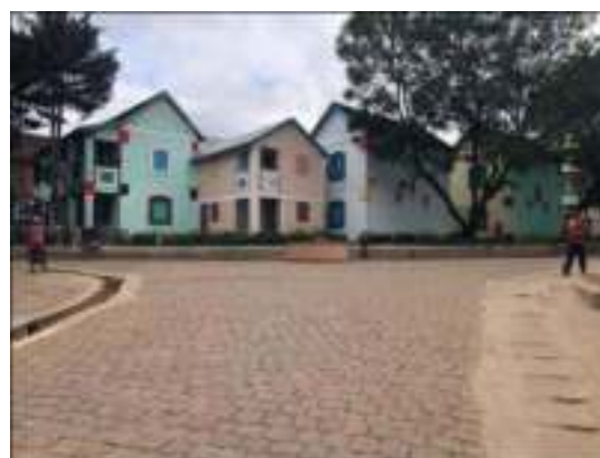
Figura 8: Viviendas del barrio Andralanitra. Fuente: Fotografía de mi autoría, diciembre de 2018.
