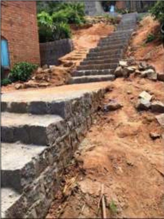
Figura 21: Construyen sus propios caminos gracias a la cantera de Akamasoa. Fuente: Fotografía de mi autoría, diciembre de 2018.
